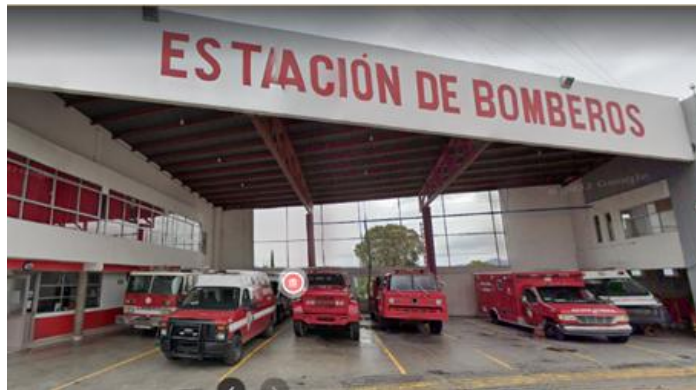
Foto 3.3.7.10. Estación de Bomberos
