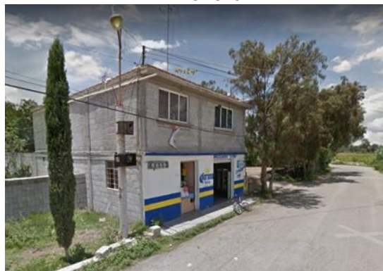
Foto 2.3.2.10 Vivienda zona urbana Boxtha
