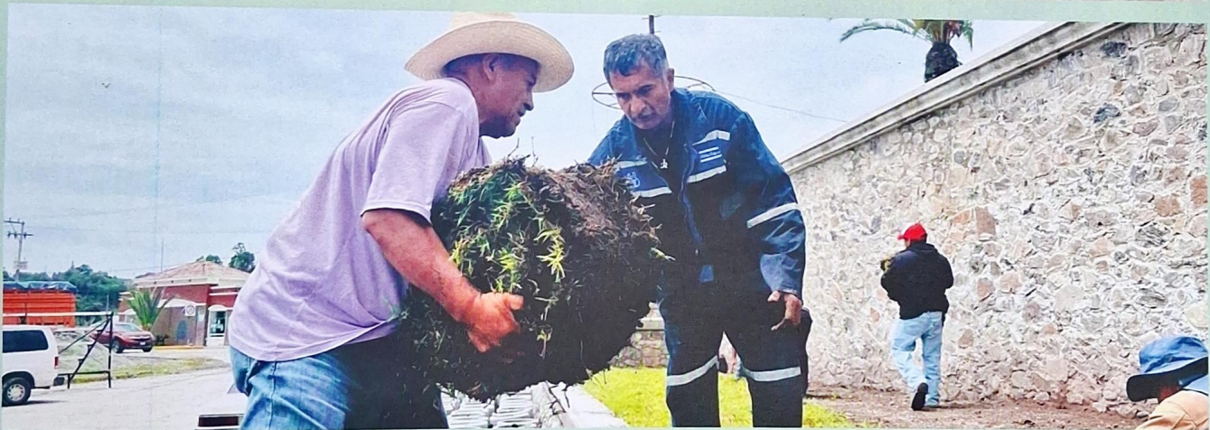
Aportación y apoyo en colocación de pasto áreas verdes la estancia
