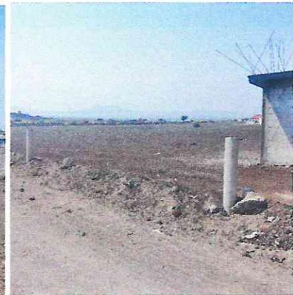
EXCAVACION EN CEPA A MANO, MATERIAL SECO TIPO II, GUARNICION DE CONCRETO HIDRAULICO PREMEZCLADO  $f'c= 150 \text{ KG/CM}^2$  CON UNA SECCION DE 15 x 20 x 40 cm., CIMBRA APARENTE EN POSTES Y COLUMNAS CIRCULARES DE 30 cm. Y 20 cm. DE DIAMETRO A BASE DE SONOTUBO
