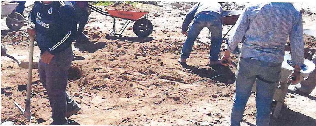
EFad0104 RELLENO COMPACTADO CON PISON DE MANO, EN CAPAS DE 20 CM. DE ESPESOR, INCLUYE: INCORPORACION DE HUMEDAD, MANO DE OBRA Y HERRAMIENTA. (NO INCLUYE: MATERIAL INERTE COMPACTABLE)
