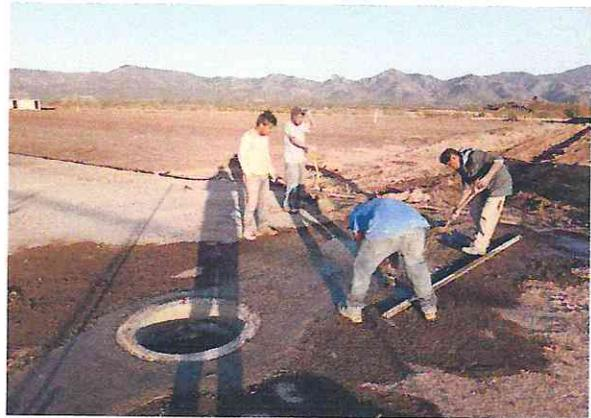
SUMINISTRO Y COLOCACION DE TUBO DE PVC SANITARIO DE 4" (100 mm.) y DE 6" (150 mm.), RELLENO A VOLTEO UTILIZANDO MATERIAL PRODUCTO DE LA EXCAVACION, POZO DE VISITA COMUN DE MURO DE TABIQUE ROJO RECOCIDO DE 0.24 m. A TIZON.
