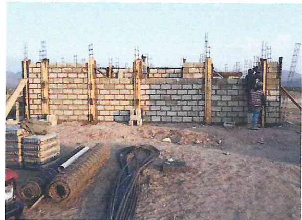
CIMBRA DE CONTACTO ACABADO COMUN EN CADENAS Y CASTILLOS. ACERO DE REFUERZO EN ESTRUCTURA CON ALAMBRO # 2 y # 3. CONCRETO HIDRAULICO HECHO EN OBRA  $f'c = 200 \text{ KG/CM}^2$  EN ESTRUCTURA.
