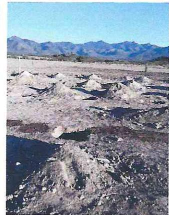
EFad0091 EXCAVACION EN CEPA A MANO, MATERIAL SECO TIPO II, TODAS LAS ZONAS, INCLUYE: AFINE DE TALUDES Y FONDO, EXTRACCION DE REZAGA A BORDE DE CEPA, TRASPALEOS, MANO DE OBRA Y HERRAMIENTA. EXCAVACION DE 0.00 A 2.00 M. DE PROFUNDIDAD. (MEDIDO COMPACTO)
