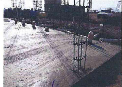
RELLENO COMPACTADO CON PISON DE MANO, EN CAPAS DE 20 CM. DE ESPESOR, FIRME DE CONCRETO HIDRAULICO HECHO EN OBRA DE F'C= 200 KG/CM2 DE 10 CM. DE ESPESOR, ACABADO CON LLANA METÁLICA, ARMADO CON MALLA ELECTROSOLDADA 6-6/10-10,
