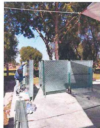
SUMINISTRO Y COLOCACION DE FIJO Y PUERTA PARA MAMPARA DE SANITARIOS, SUMINISTRO Y COLOCACIÓN DE PUERTA A BASE DE PERFIL TUBULAR CALIBRE 18 CON TABLERO DE LAMINA CALIBRE 20 TIPO CAJA EN TODA LA PUERTA, SUMINISTRO E INSTALACION DE VENTANAS DE FIERRO.
