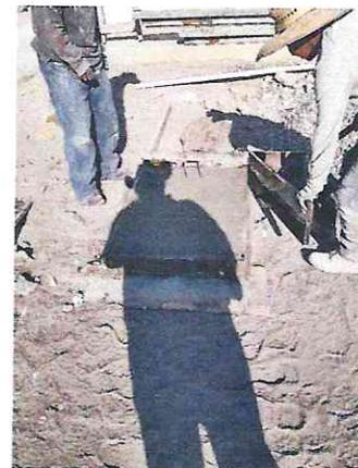
REGISTRO SANITARIO DE 60x60x80 cm. (MEDIDAS INTERIORES) A BASE DE BLOCK Y MURO DE CONCRETO SIMPLE, APLANADO PULIDO MORTERO CEMENTO-ARENA 1:3 EN MUROS INTERIORES, INCLUYE: TAPA DE CONCRETO f'c= 150 Kg/cm<sup>2</sup> DE 5 cm. DE ESPESOR, PLANTILLA CON CONCRETO f'c= 100 Kg/cm<sup>2</sup> DE 5 cm. DE ESPESOR, MATERIALES, MANO DE OBRA Y HERRAMIENTA
