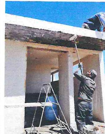
ACABADO FINO EN MUROS Y PLAFONES A BASE DE ESTUCO ACRILICO BLANCO EN 15 mm. DE ESPESOR PROMEDIO, APLICADO CON LLANA METALICA, SOBRE SUPERFICIES LISAS PREVIAMENTE PREPARADAS Y SELLADAS. EMBOQUILLADO EN APLANADO PERFILANDO DOS ARISTAS CON MORTERO CEMENTO-CAL-ARENA 1:1:6. A PLOMO Y REGLA, ACABADO CON LLANA DE MADERA.
