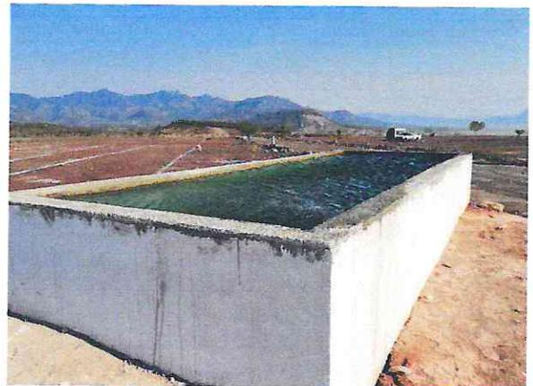
MURO DE BLOCK MACIZO DE CEMENTO 14 x 20 x 40 cm. DE 14 cm. DE ESPESOR, ASENTADO CON MORTERO CEMENTO-ARENA 1:3, APLANADO EN MUROS CON MORTERO CEMENTO-ARENA 1:3 A PLOMO Y REGLA ACABADO CON LLANA DE MADERA DE 2.50 cm., ACABADO FINO EN MUROS Y PLAFONES A BASE DE ESTUCO ACRILICO BLANCO EN 15 mm. , CHAFLAN DE 5 x 5 cm., EMBOQUILLADO EN APLANADO PERFILANDO DOS ARISTAS CON MORTERO.
