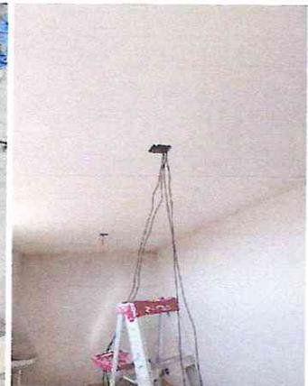
SALIDA PARA ALUMBRADO, INCLUYE: TENDIDO DE POLIDUCTO REFORZADO DE ½", BOTE INTEGRAL DE 10 A 12 cm., (12 m) DE CABLE THW DEL # 12, SALIDA PARA CONTACTO MONOFASICO DUPLEX POLARIZADO, SUMINISTRO Y COLOCACION DE APAGADOR SENCILLO DE 127 V, SUMINISTRO Y COLOCACIÓN DE CENTRO DE CARGA TIPO QOD4F DE 4 X 60 AMP, SUMINISTRO Y COLOCACION DE INTERRUPTOR TERMOMAGNETICO DE 1x15 A 1x50 AMP., SUMINISTRO Y COLOCACIÓN DE LUMINARIA ARBOTANTE (SOCKET PORCELANA).
