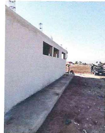
GUARNICION DE CONCRETO HIDRAULICO PREMEZCLADO  $f'c= 150 \text{ KG/CM}^2$  CON UNA SECCION DE 15 x 20 x 40 cm.,
