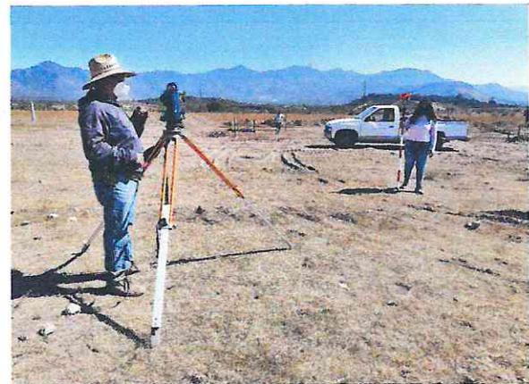
EFad0080 TRAZO Y NIVELACION DE TERRENO PARA DESPLANTE DE ESTRUCTURA, MENORES DE 400 M2 , ESTABLECIENDO REFERENCIAS Y BANCOS DE NIVEL, CON EQUIPO TOPOGRAFICO, INCLUYE: MANO DE OBRA, EQUIPO Y HERRAMIENTA
