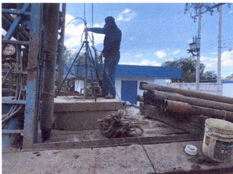
Fotografía 2. _ Colocación de la sonda de registros
