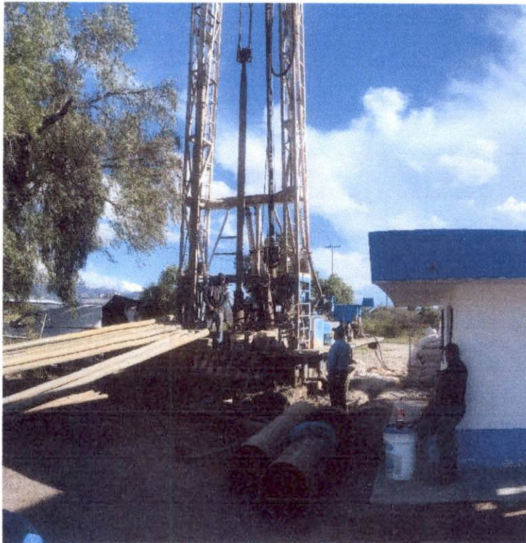
Fotografía 1. _ Sitio de trabajos de perforación
