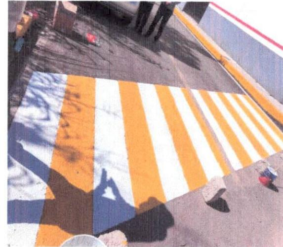
Efc0786 SUMINISTRO Y APLICACIÓN DE PINTURA TRAFICO AMARILLO (RA-S B/SOL) O BLANCO (RB-S B/SOL) EN PASOS PEATONALES, CON APLICACIÓN DE MICROESFERA REFLEJANTE CLSE A RAZON DE 0.70 KILOS POR LITRO DE PINTURA (ESPECIFICACION DE FABRICANTE), INCLUYE : MATERIAL, MANO DE OBRA Y HERRAMIENTA.
