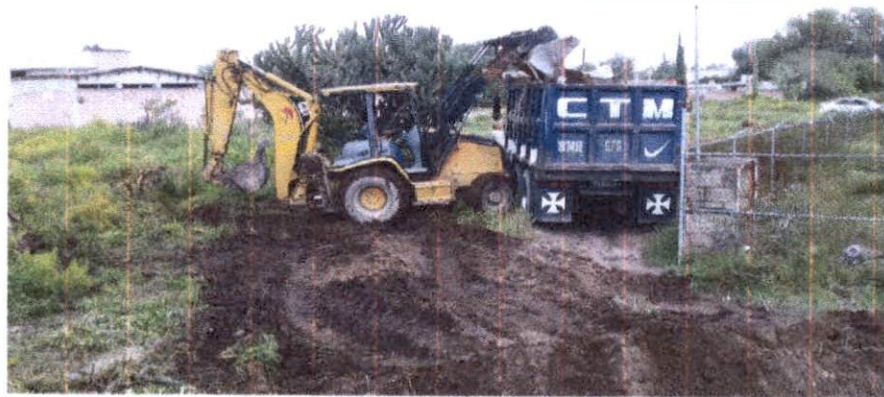
AXC0031 ACARREO A 1er. KM. EN CAMION CON CARGA MECANICA DE MATERIALES PRODUCTO DE DEMOLICIONES Y EXCAVACIONES HASTA EL SITIO AUTORIZADO. (MEDIDO COMPACTO)
