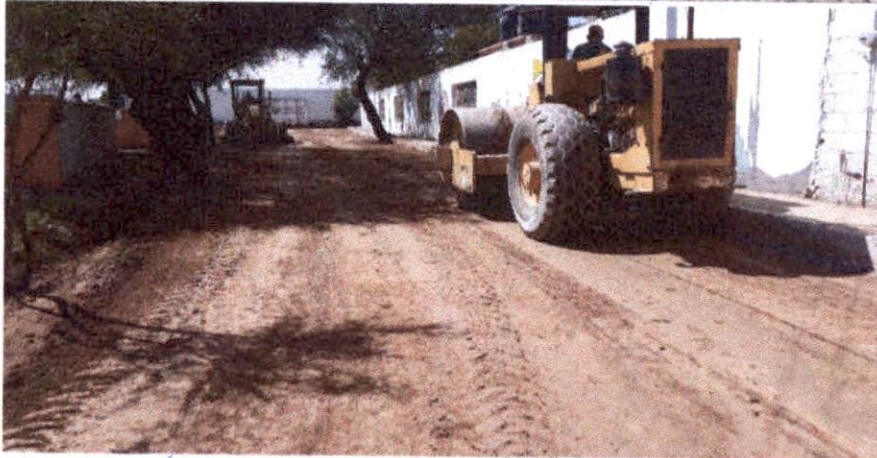
Cmc0217 086-E.02 OPERACION DE MEZCLADO, TENDIDO Y COMPACTACIÓN EN LA CONSTRUCCION DE SUB-BASES O BASES: B) DE BASES: 1) CUANDO SE EMPLEE UN MATERIAL PETREO: a) COMPACTADO AL 95%
