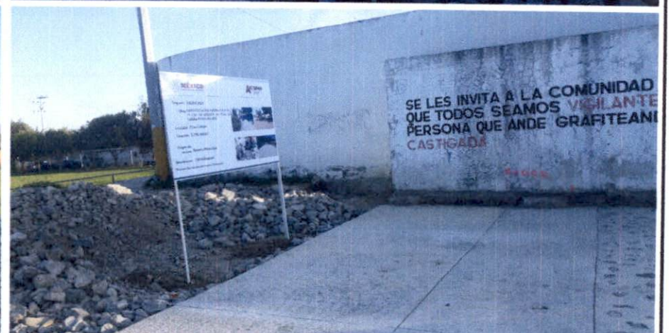
Efc0191 SUMINISTRO Y COLOCACION DE MAMPARA INFORMATIVA DE 1.20 x 2.00 m. A BASE DE LAMINA CAL. 18, CON BASTIDOR DE ANGULO DE 1½" x 1/8", CON UN SOPORTE TRANSVERSAL-VERTICAL AL CENTRO Y SOPORTE CON ANGULO DE 1½" x 1/8" AHOGADO AL PISO 60 cm. Y 1.17 m. DE ALTURA LIBRE DEL NIVEL DEL PISO
