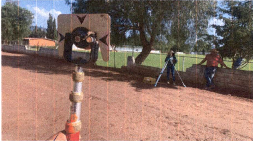
EFc0083 TRAZO Y NIVELACION DE PLAZAS, ANDADORES, BANQUETAS Y PAVIMENTOS PRIMEROS 10,000 M2, ESTABLECIENDO REFERENCIAS Y BANCOS DE NIVEL, CON EQUIPO TOPOGRAFICO, INCLUYE: MANO DE OBRA, EQUIPO Y HERRAMIENTA
