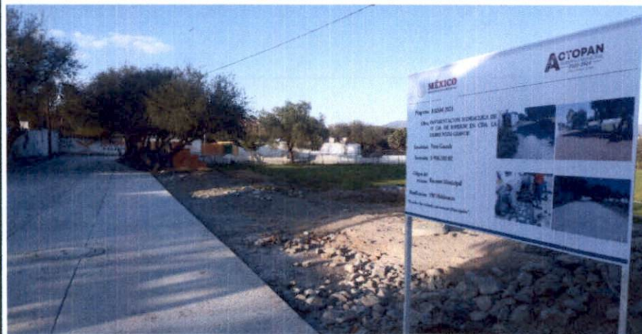
Efc0191 SUMINISTRO Y COLOCACION DE MAMPARA INFORMATIVA DE 1.20 x 2.00 m. A BASE DE LAMINA CAL. 18, CON BASTIDOR DE ANGULO DE 1½" x 1/8", CON UN SOPORTE TRANSVERSAL-VERTICAL AL CENTRO Y SOPORTE CON ANGULO DE 1½" x 1/8" AHOGADO AL PISO 60 cm. Y 1.17 m. DE ALTURA LIBRE DEL NIVEL DEL PISO
