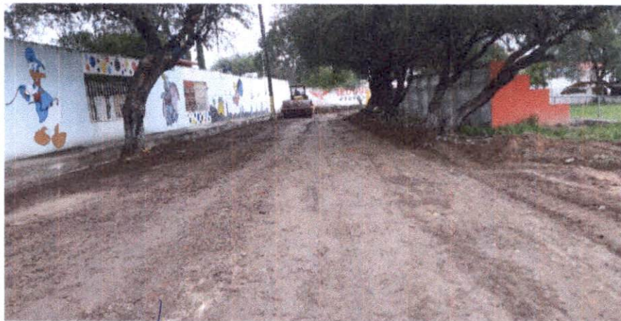
CmC0038 009-F.02 COMPACTACIONES: A) DEL TERRENO NATURAL EN EL ÁREA DE DESPLANTE DE LOS TERRAPLENES: 2) PARA 90%
