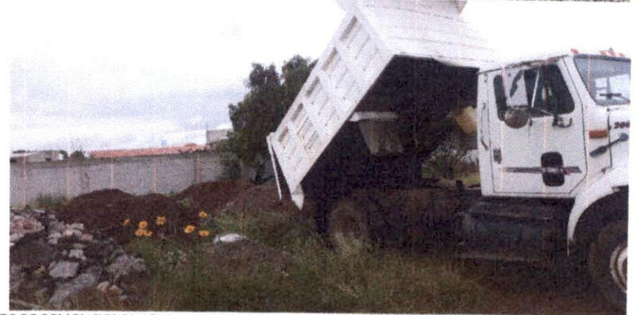
AXc0032 ACARREO KMS. SUBSECUENTES EN CAMION CON CARGA MANUAL DE MATERIALES PRODUCTO DE DEMOLICIONES Y EXCAVACIONES HASTA EL SITIO AUTORIZADO. (MÉTODO COMPACTO)
