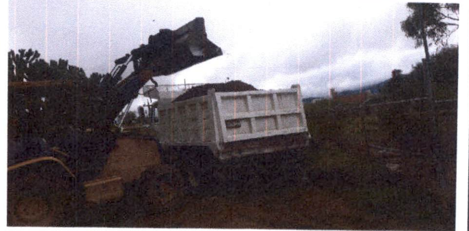
AXC0031 ACARREO A 1er. KM. EN CAMION CON CARGA MECANICA DE MATERIALES PRODUCTO DE DEMOLICIONES Y EXCAVACIONES HASTA EL SITIO AUTORIZADO. (MEDIDO COMPACTO)
