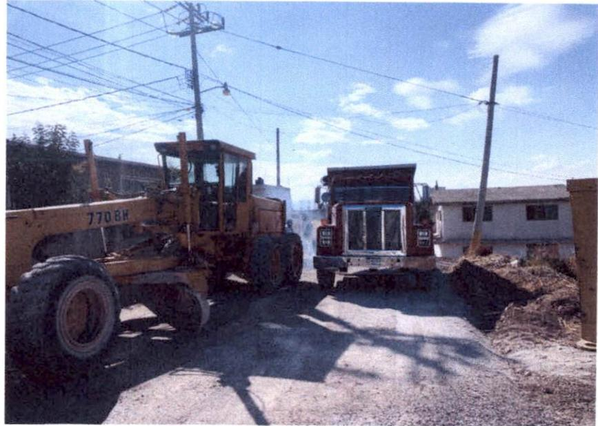
AXC0036 ACARRO KMS. SUBSECUENTES EN CAMION CON CARGA MECANICA DE MATERIALES ASFALTICOS Y PETREOS SELECCIONADOS PARA LA CONSTRUCCION DE SUB-BASES Y BASES
