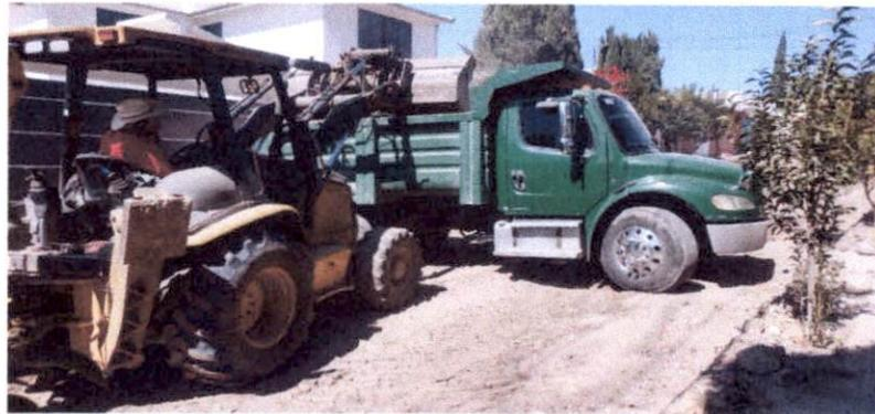
AXC0031 ACARREO A 1.07 KM. EN CAMION CON CARGA MECANICA DE MATERIALES PRODUCTO DE DEMOLICIONES Y EXCAVACIONES HASTA EL SITIO AUTORIZADO. (MEDIDO COMPACTO)
