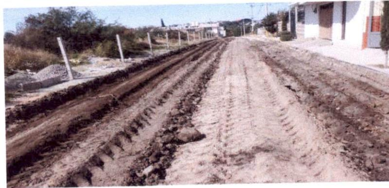
EFC0099 EXCAVACION DE CORTE EN CAJA, CON MAQUINARIA EN MATERIAL "B", SECO, EN SUPERFICIES MAYORES A 1,200 M2, INCLUYE: ACAMELLONAMIENTO, AFINE DE CORTES, ACARREO LIBRE Y AFINE DE LOS CORTES, MANO DE OBRA, EQUIPO Y HERRAMIENTA. (MEDIDO COMPACTO)
