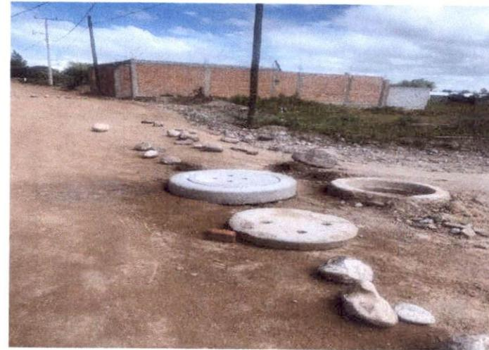
EFc0189 RENIVELACION DE POZO DE VISITA (30 cm. PROMEDIO), INCLUYE: RETIRO DE BROCAL, APLANADO CON MORTERO CEMENTO ARENA 1:3 ACABADO PULIDO EN EL INTERIOR, SUMINISTRO Y COLOCACION DE BROCAL Y TAPA DE CONCRETO NUEVO, DESAZOLVE Y RETIRO DE ESCOMBRO FUERA DE LA OBRA, LIMPIEZA FINAL, MANO DE OBRA Y HERRAMIENTA.
