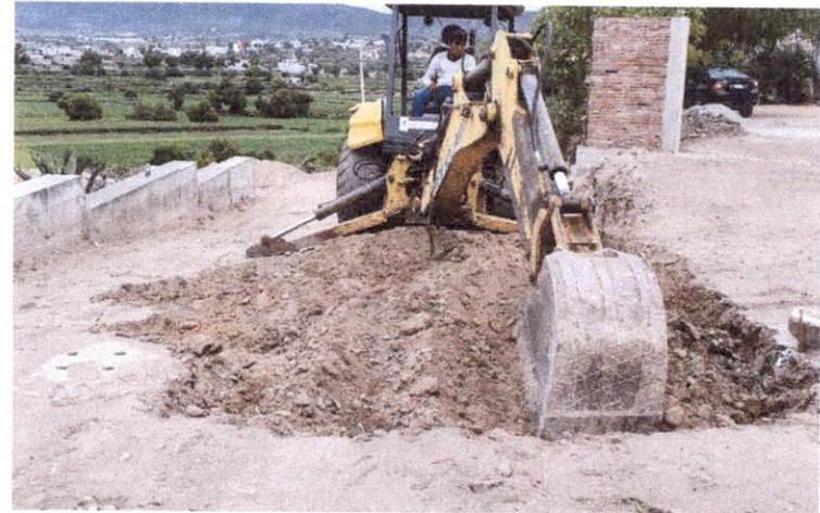
EFc0099 EXCAVACION DE CORTE EN CAJA, CON MAQUINARIA EN MATERIAL "B", SECO, EN SUPERFICIES MAYORES A 1,200 M2, INCLUYE: ACAMELLONAMIENTO, AFINE DE CORTES, ACARREO LIBRE Y AFINE DE LOS CORTES, MANO DE OBRA, EQUIPO Y HERRAMIENTA. (MEDIDO COMPACTO)
