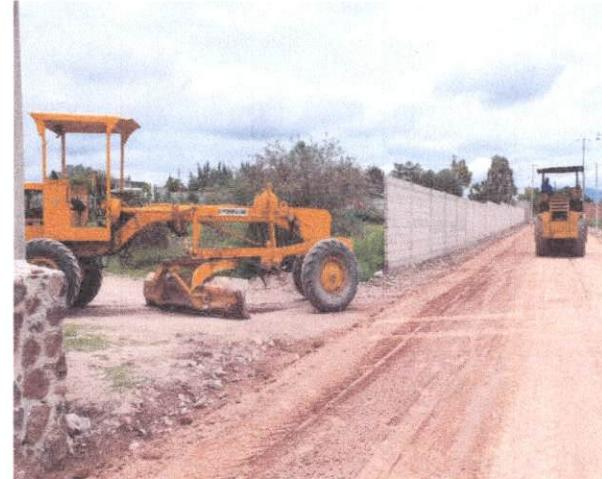
CMc0212 086-E.02 OPERACION DE MEZCLADO, TENDIDO Y COMPACTACIÓN EN LA CONSTRUCCION DE SUB-BASES O BASES: A) DE SUB-BASES: 1) CUANDO SE EMPLEE UN MATERIAL PETREO: a) COMPACTADO AL 95%
