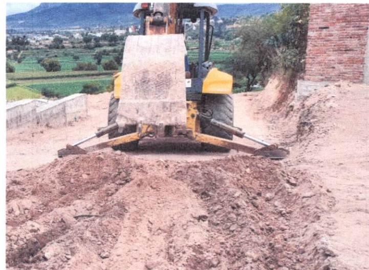
Efc0099 EXCAVACION DE CORTE EN CAJA, CON MAQUINARIA EN MATERIAL "B", SECO, EN SUPERFICIES MAYORES A 1,200 M2, INCLUYE: ACAMELLONAMIENTO, AFINE DE CORTES, ACARREO LIBRE Y AFINE DE LOS CORTES, MANO DE OBRA, EQUIPO Y HERRAMIENTA. (MEDIDO COMPACTO)
