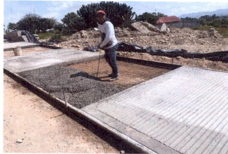
EFc0218 PISO PARA PAVIMENTO DE CONCRETO HIDRAULICO HECHO EN OBRA  $f'c = 200 \text{ KG/CM}^2$  DE 15 cm. DE ESPESOR, ACABADO PULIDO RAYADO, ACABADO CON VOLTEADOR EN PERIMETRO, CUADROS DE 3.00 X 3.00 m., CURADO, MALLA ELECTROSOLDADA 6-6/10-10, INCLUYE: ELABORACION DE CONCRETO, CIMBRA METALICA A LA ALTURA DEL ESPESOR DE LA LOSA, DESCIMBRADO, ACARREOS DE MATERIAL PARA ELABORAR CONCRETO, LIMPIEZA FINAL DE OBRA, MATERIALES, MANO DE OBRA Y HERRAMIENTA. (P.U.O.T)
